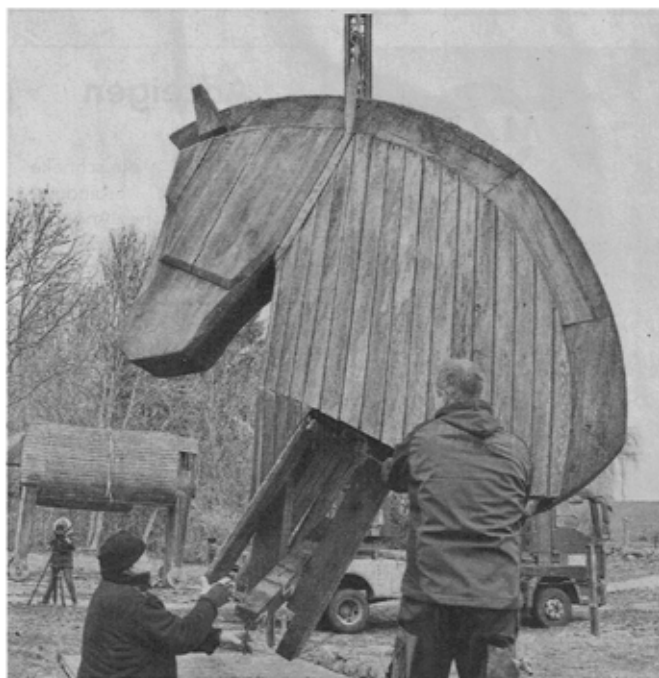
Das alte, 22 Jahre alte Trojanische Pferd wurde demon- tiert. Bis zum Juni wird es – angelehnt an die alten Bau- pläne – durch ein neues ersetzt. Foto: S. Salzmann
